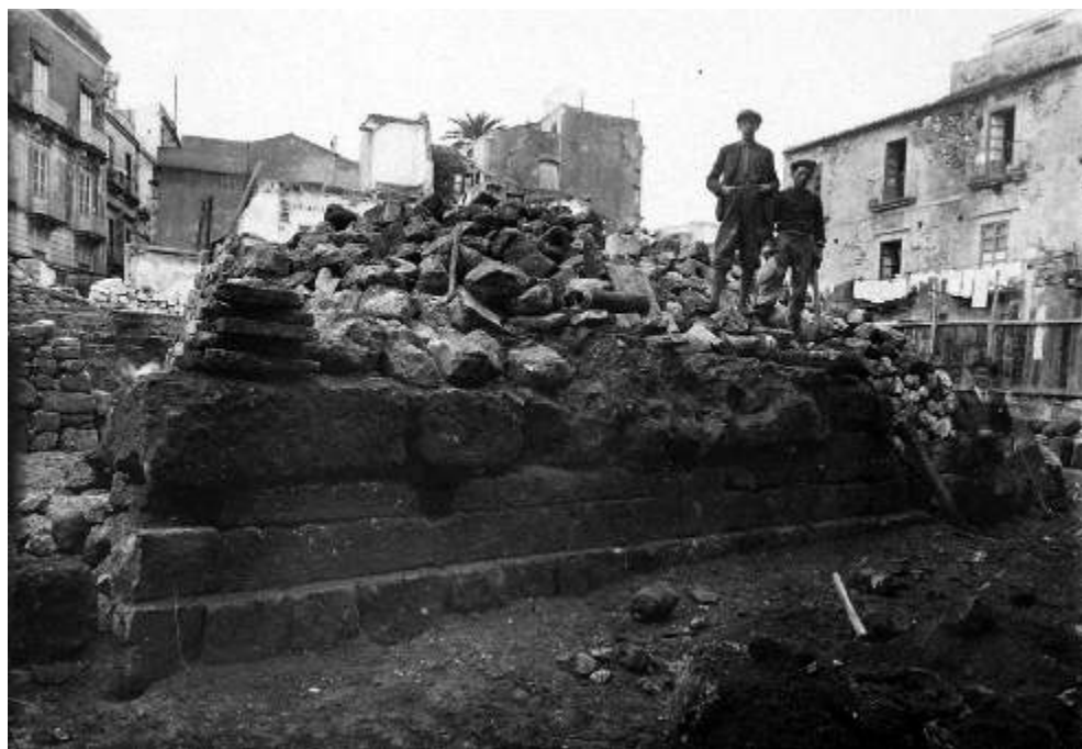
Fig. 5. Scavi per la costruzione del Banco di Sicilia. (Archivio Fotografico Soprintendenza Beni Culturali, Siracusa)
