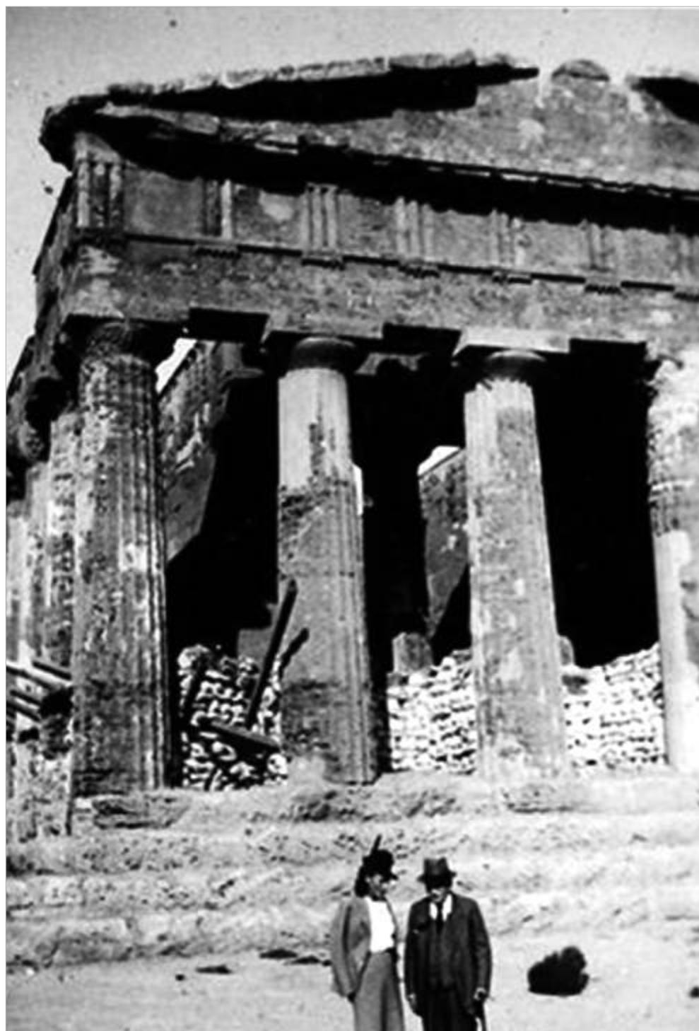
Fig. 3. Smontaggio dei sacchi di sabbia da parte di P. Griffo
