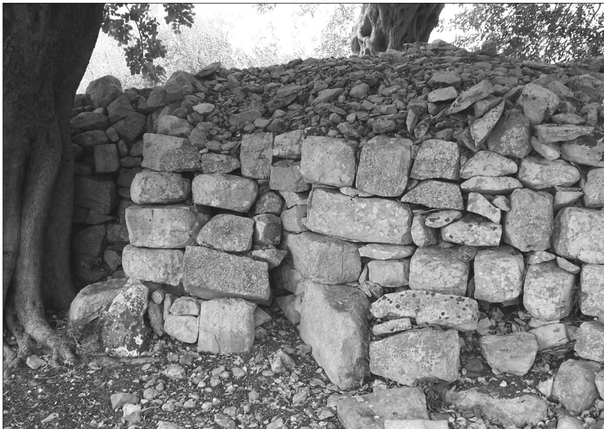
Fig. 6. Ciaceri-Cammaratini. Strutture murarie in tecnica megalitica inglobate in muri a secco
